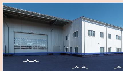
Infrastructure du bâtiment
